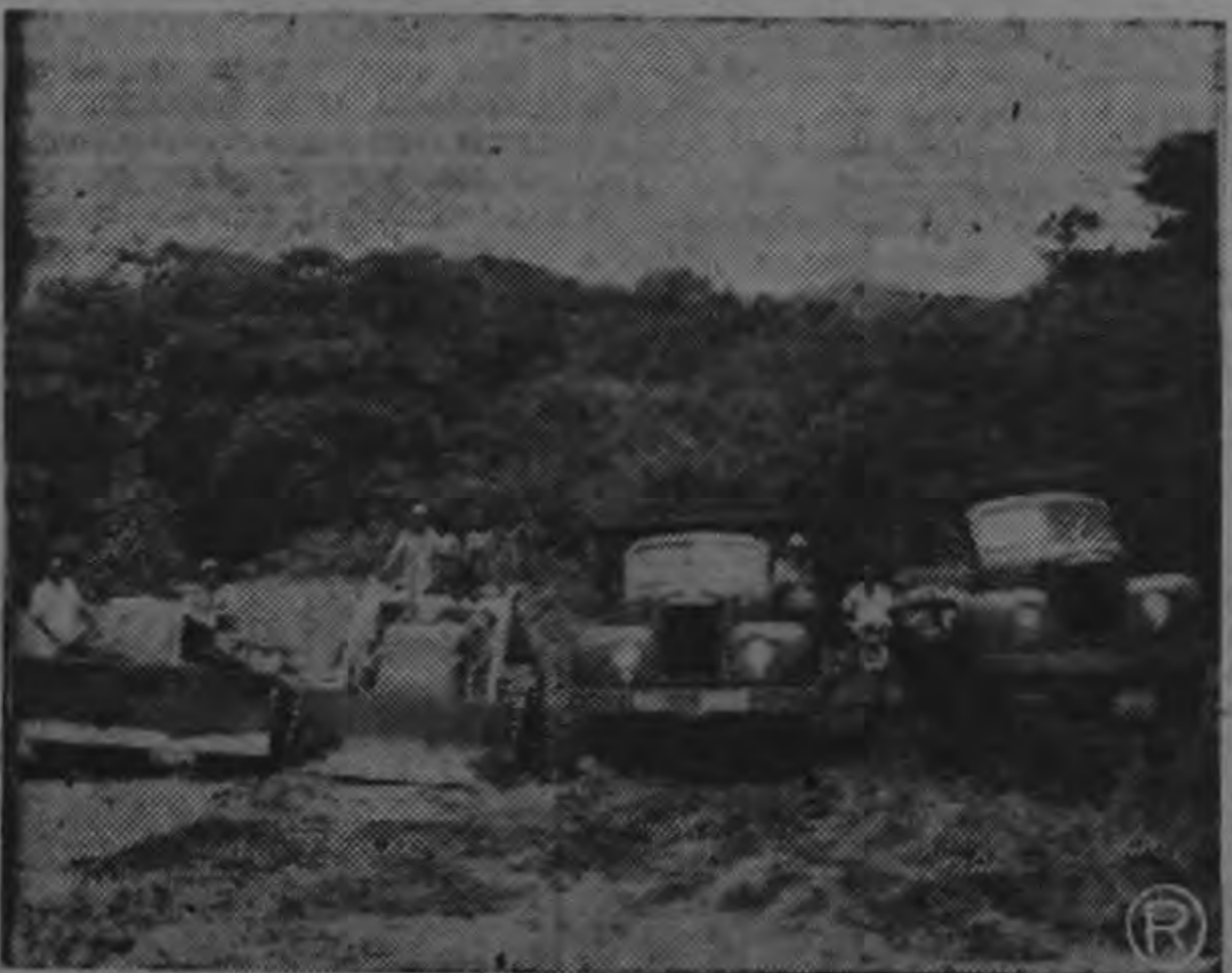
EQUIPO VIAL. — Podemos apreciar en la gráfica parte del equipo vial con que cuenta la Municipalidad de Santa Cruz. Un tractor D-4, una pala mecánica y dos de las tres vagonetas de que se dispone para los trabajos del cantón.
