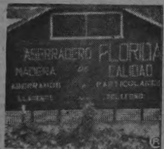
Costado de la casa de máquinas de la planta que da a la vía férrea
